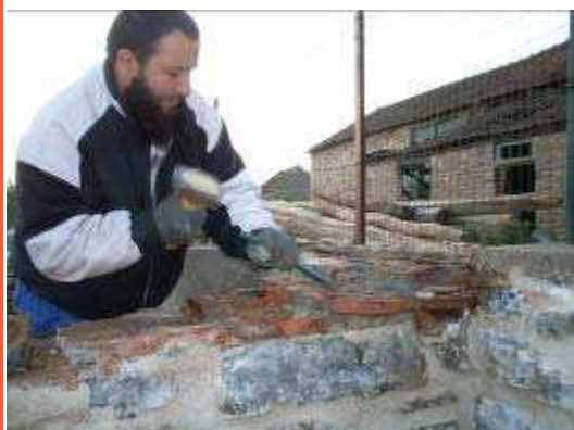
Karim à l'œuvre pour préparer l'assise de la nouvelle couverture
