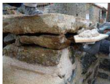
Calage à l'aide de pierres et jointoiement à la chaux
